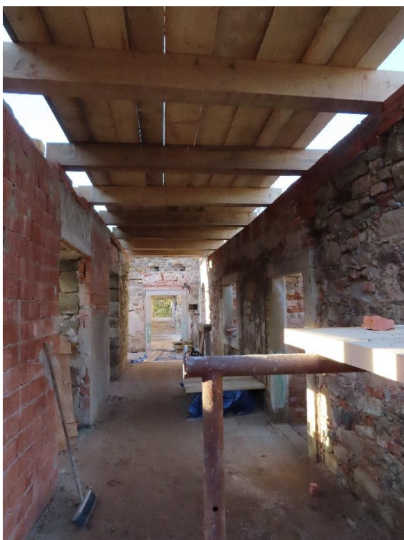
Na počátku podzimu roku 2022 stavba dospěla až ke koruně zdiva a zároveň pokračovala zajištěním zdiva středního zámeckého křídla. Možná se i ono dočká kompletní rekonstrukce.
