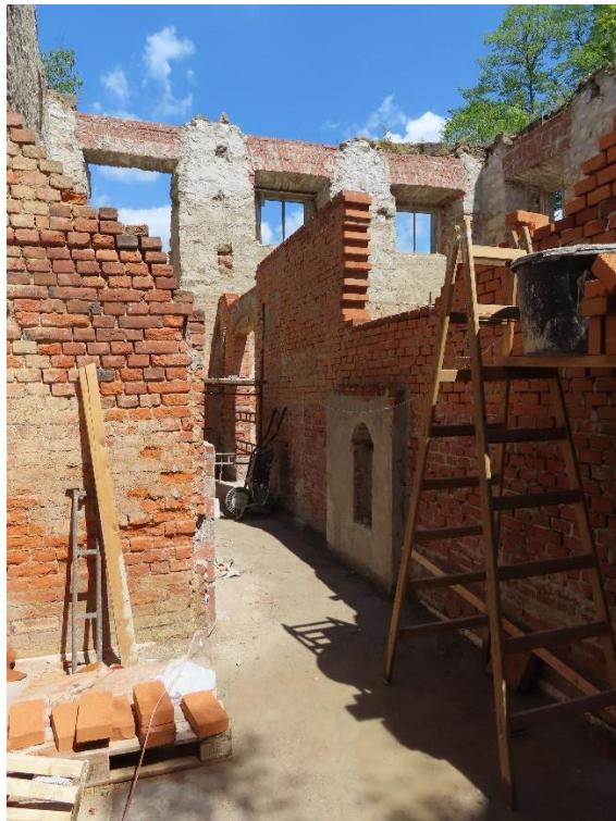
Začíná stavební obnova severního křídla. Nejdříve klenby v přízemí, později dozdivání zaniklých stěn a vlastně nové vytváření původních interiérů
