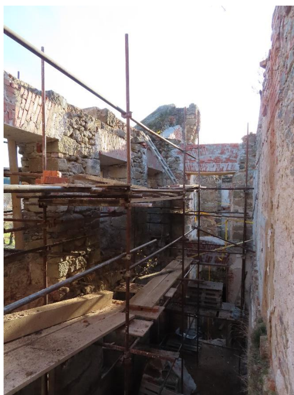
Na počátku podzimu roku 2022 stavba dospěla až ke koruně zdiva a zároveň pokračovala zajištěním zdiva středního zámeckého křídla. Možná se i ono dočká kompletní rekonstrukce.
