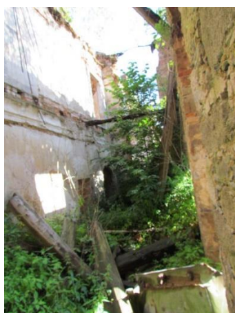
Stav interiéru zámku v roce 2011
