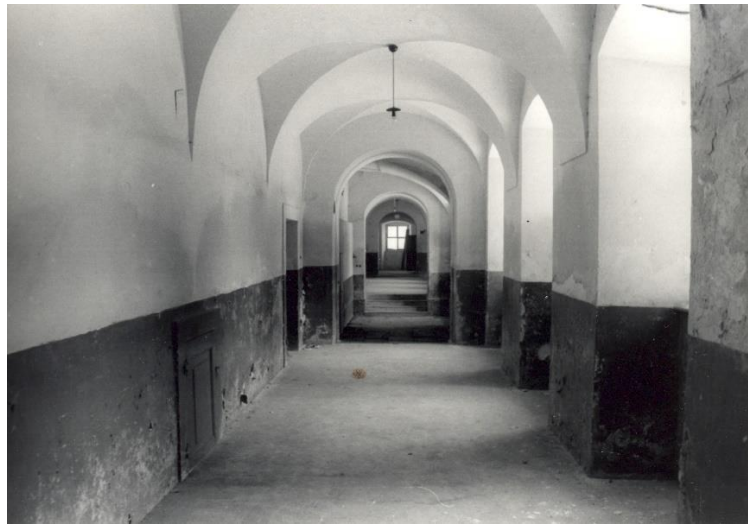
Interiér – spojovací chodba I. NP po opuštění objektu armádou
