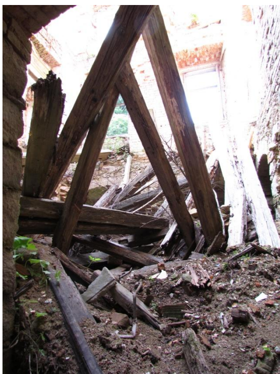
Interiéry východního konce severovýchodního křídla, nejzničenější části zámku před sanací a likvidací trámových konstrukcí a zbytků konstrukcí zděných příček.
