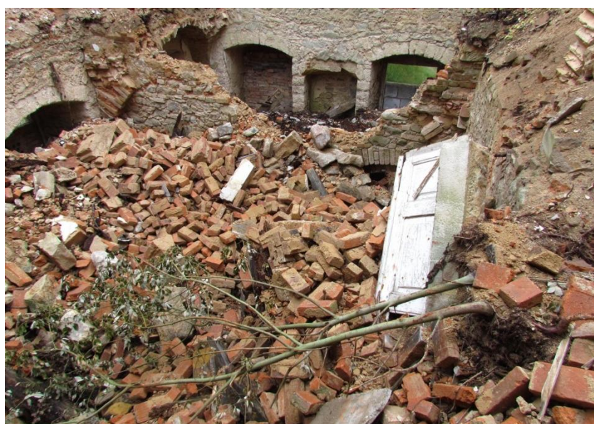
Tentýž prostor po provedené sanaci a před odstraněním zříceného zdiva
