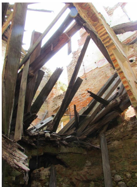
Interiéry východního konce severovýchodního křídla, nejzničenější části zámku před sanací a likvidací trámových konstrukcí a zbytků konstrukcí zděných příček.
