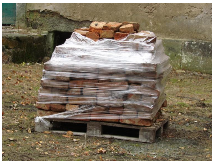
Vybourané a použitelné původní cihly připravené k novému zazdění
