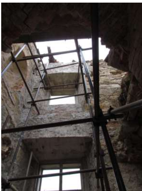
Sanovaná vnější zeď hlavního schodiště včetně nadpraží oken a přilehlé střední nosné zdi
