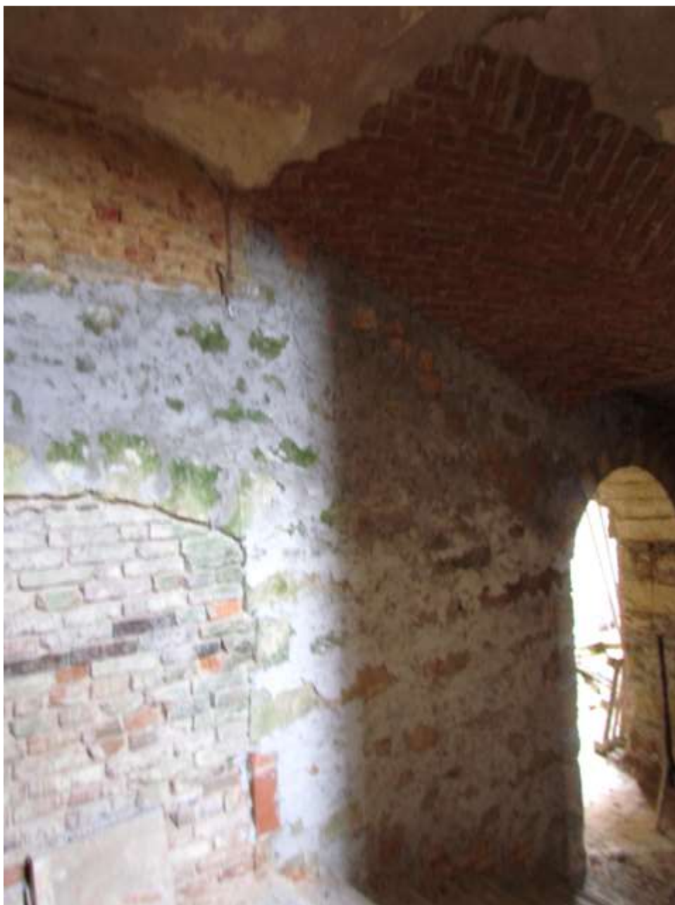
Sanovaná a dozděná nosná zeď hlavního schodiště a schodišťová klenba, která se částečně na počátku roku 2019 zřítila. Práce byly prováděny nad rámec poskytnutých finančních prostředků z PZAD
