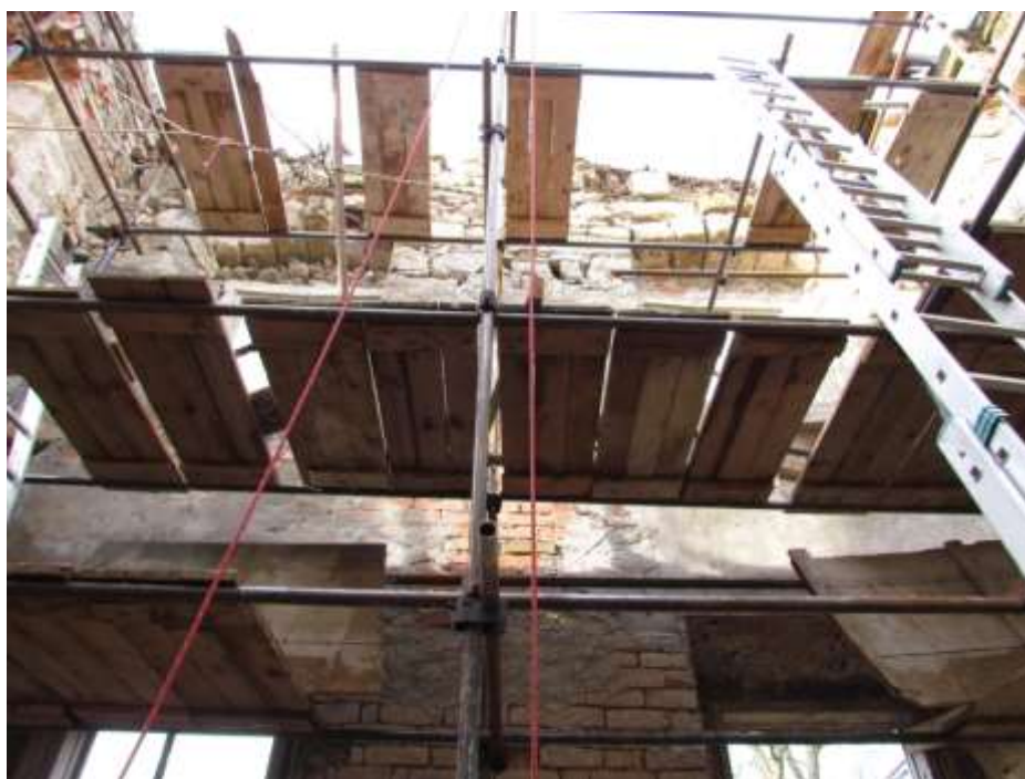
Interiérová strany severozápadního nároží při provádění sanaci zdiva a nadpraží oken
