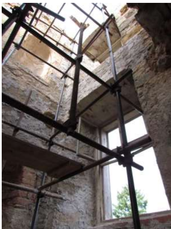
Sanovaná vnější zeď hlavního schodiště včetně nadpraží oken a přilehlé střední nosné zdi
