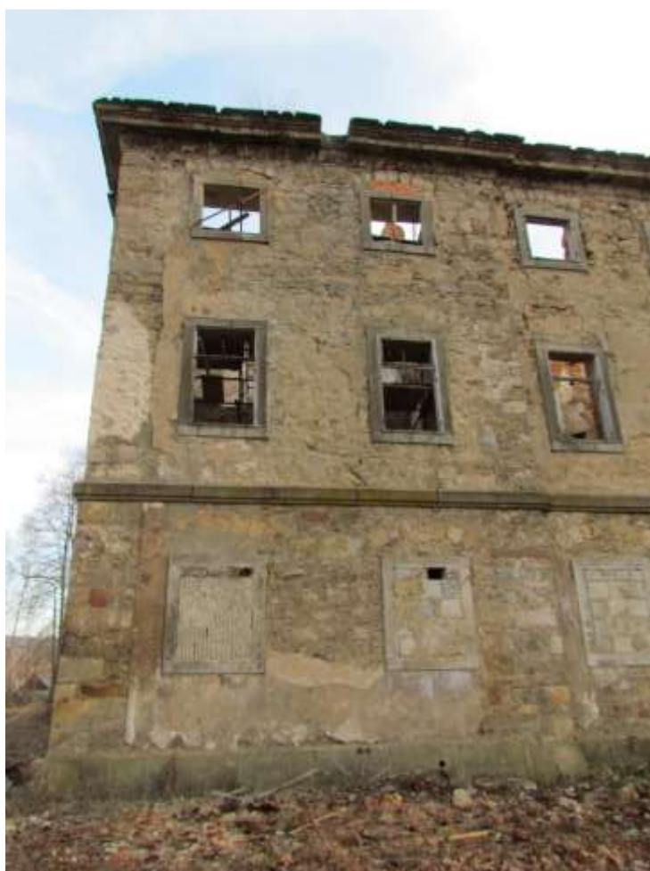
Severozápadní nároží zámku po provedené stavební sanaci
