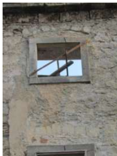
Detaily okenních otvorů a ploch obvodových zdí se sanovanými statickými poruchami z vnější strany nosných obvodových zdí
