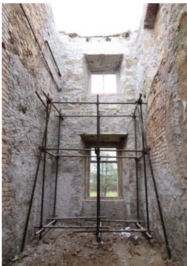
Sanovaná místnost II a III NP severního křídla
