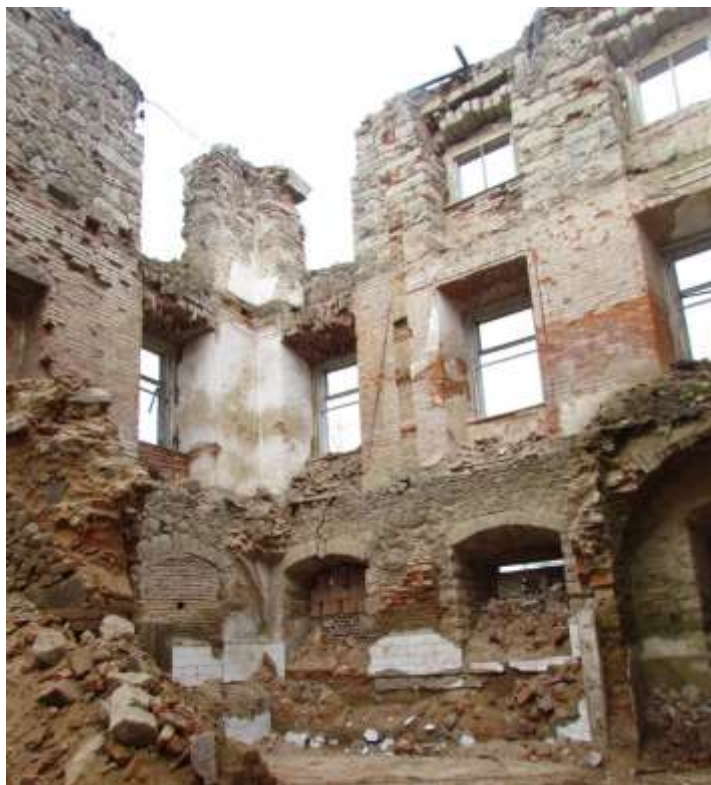
TORZO SEVERNÍHO KŘÍDLA ZÁMKU PŘED REKONSTRUKCÍ
