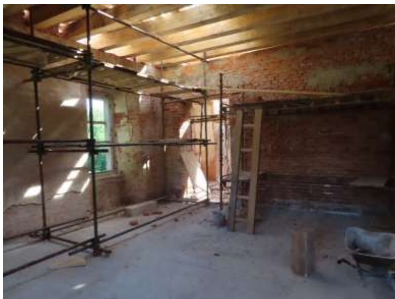
PRVNÍ PATRO JE NOVĚ ZASTROPOVÁNO ZÁKLOPOVÝMI STROPY
