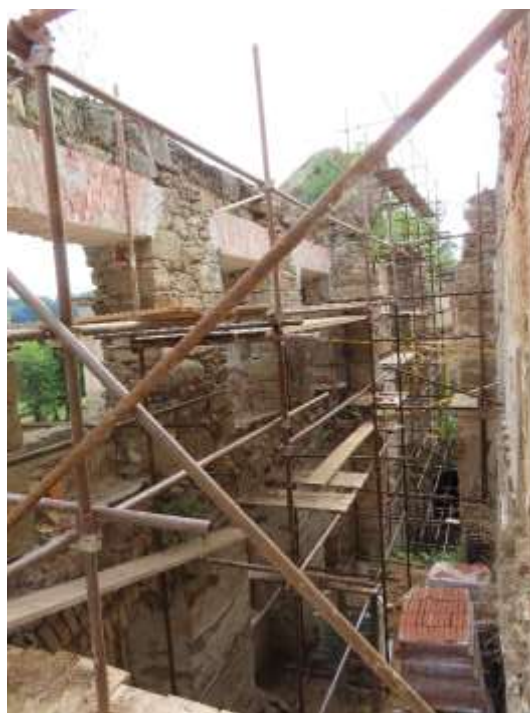
NOVÝM ZDIVEM SANOVANÉ STŘEDNÍ KŘÍDLO
