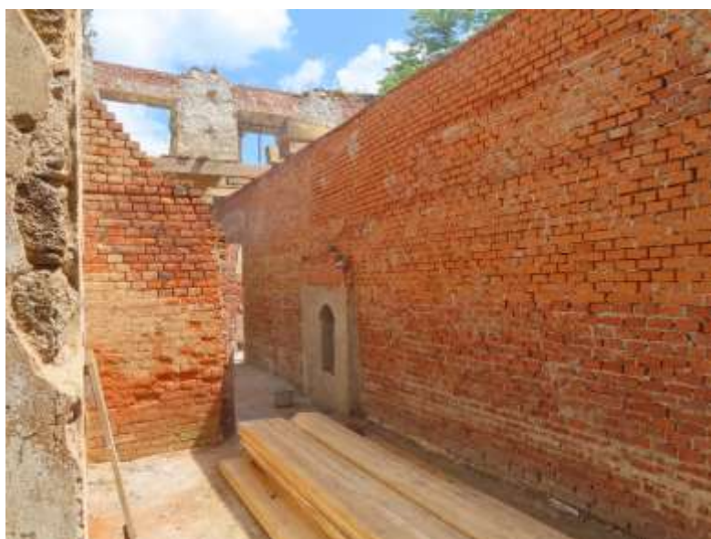
NOVĚ VYZDĚNÉ PŘÍČKY PRVNÍHO PATRA SEVERNÍHO KŘÍDLA
