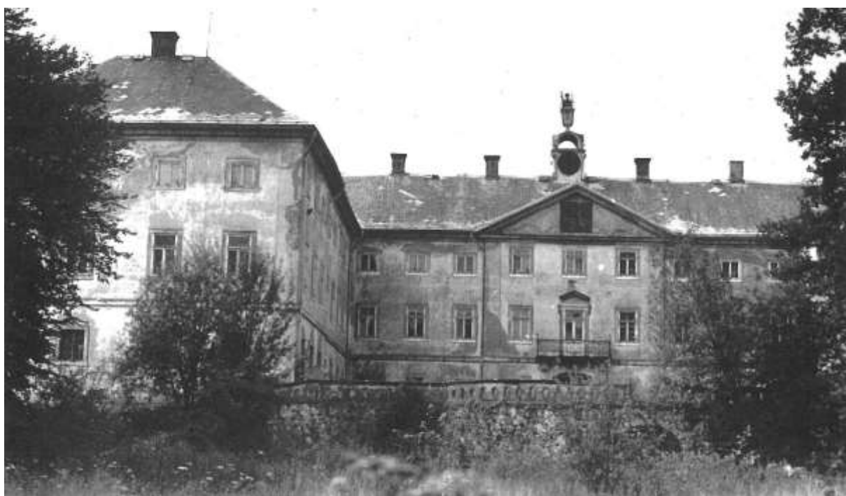
DEVADESÁTÁ LÉTA POHLEDEM NA EXTERIER BUDOVY
